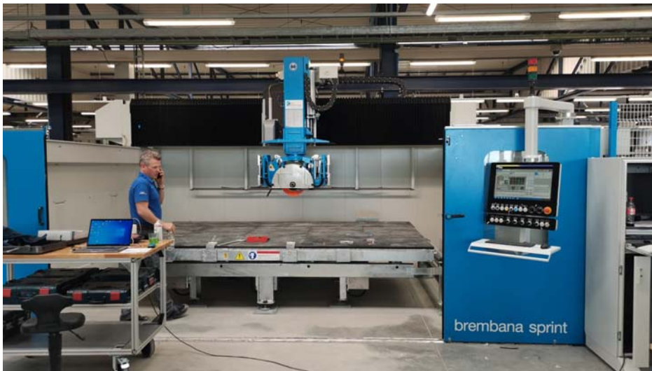
Aufbau und Inbetriebnahme der Brückensäge.
